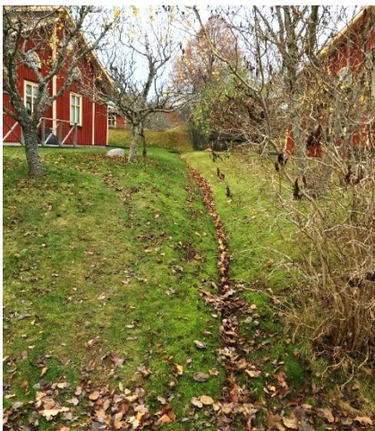
TV: Litet svackdike i tomtgräns. Referensexempel från Ekobyn i Ljungarum, Jönköping. TH: Svackdike kantat av syrén, WSP
