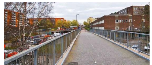
Gång och cykelbron
