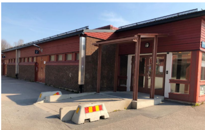
Sporthallens västra fasad med huvudentré.
