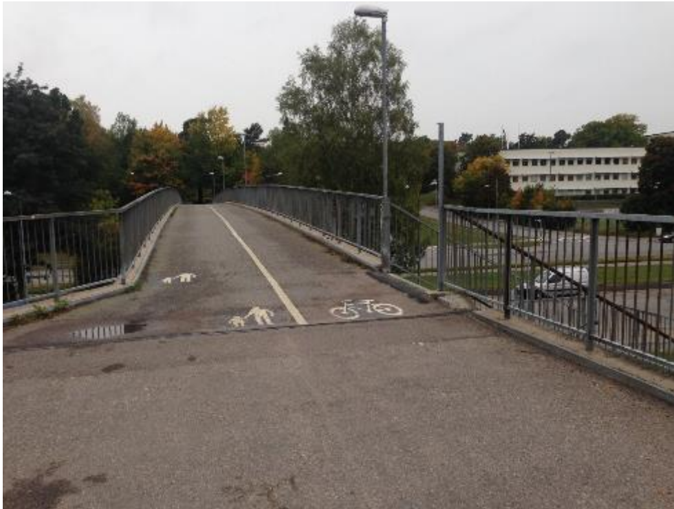
Figur 2-11 Dålig sikt. På gångbron leder trappan från parkeringen rätt ut i cykelbanan.
