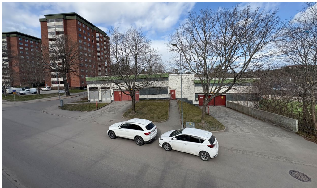
Parkeringshuset sett från söder.
