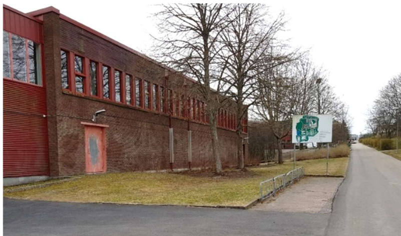
Cykelparkering av äldre modell på norra sida av sporthallen.
