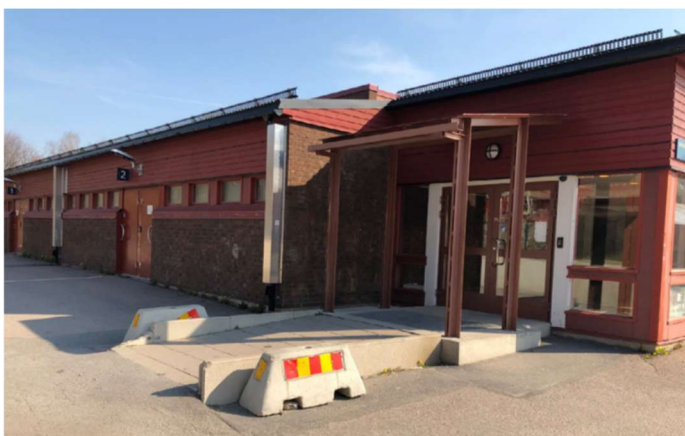
Sporthallens västra fasad med huvudentré.
