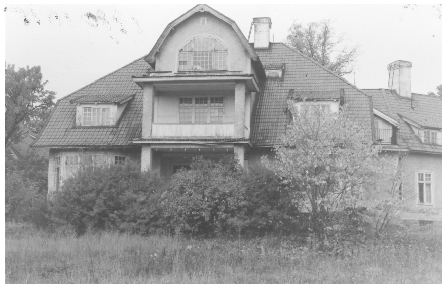
Gångsätra Gård kort innan rivningen 1981. Fasad mot syd-sydost. Foto från byggnadsnämndens rivningslovshandlingar.
