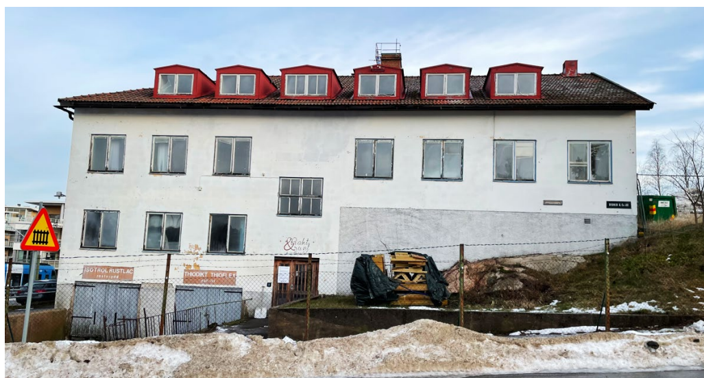
Den "trappande" sockeln på den vita byggnaden och det synliga berget i dagen vittnar om fastighetens kuperade karaktär.
