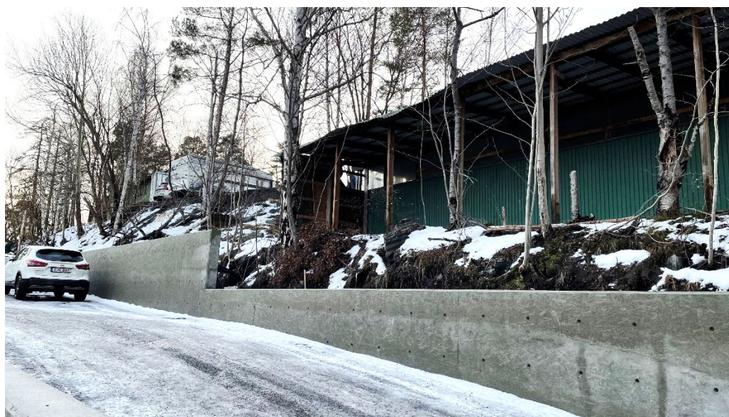
Fastigheten Lyftkranen 2 med slänt som möts av ett L-stöd av betong på intilliggande fastighet Lyftkranen 3 (Bonver Logistics).
