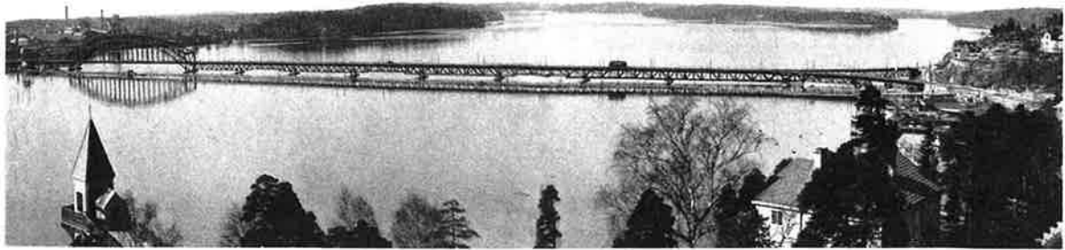
GAMLA LIDINGÖBRON SEDD FRÅN HERSERUD MOT NORR. FOTO UR BOKEN NYA LIDINGÖBRON FRÅN 1928
