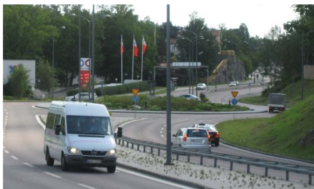
Bild: Södra Kungsvägen
