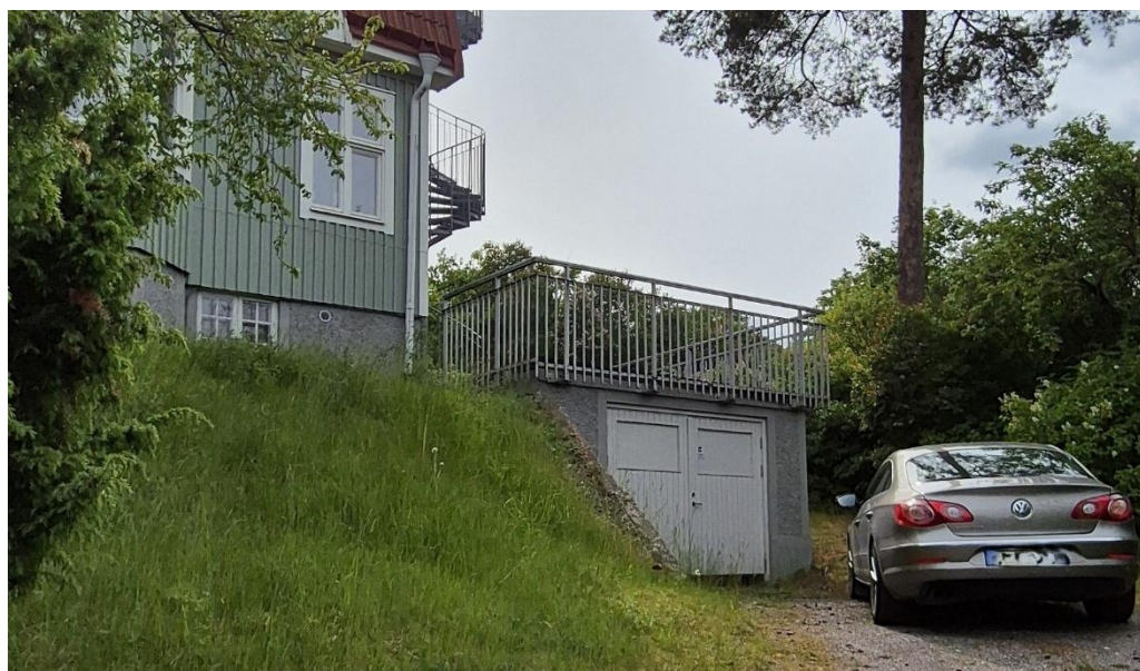
Garaget inom fastigheten Prunus 7. Foto: Lidingö stad
