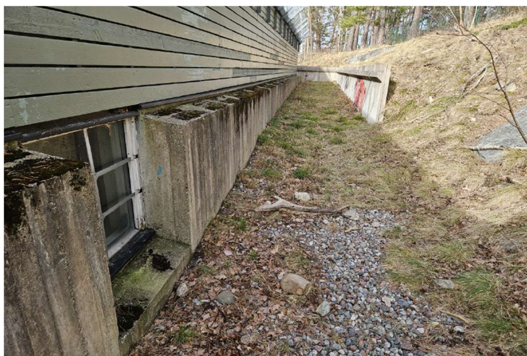
Bergsyta som överlagras av gräs och skog vid planområdets norra byggnad (Killingens förskola). Notera fönster relativt nära markytan.
