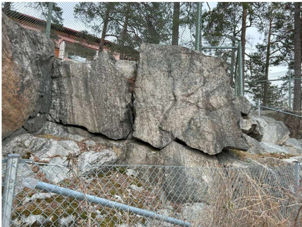
Exempel på område med risk för ras av lösa block i den östra delen av fastighet Vaktmästaren 8.
