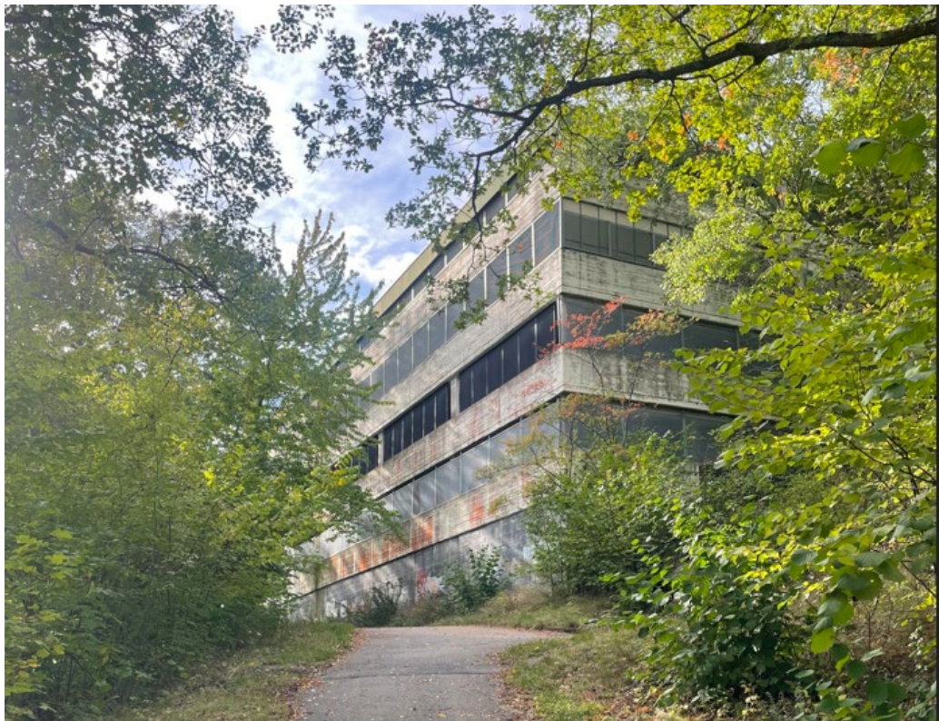
Parkeringshuset sett från gång- och cykelvägen i öster.
