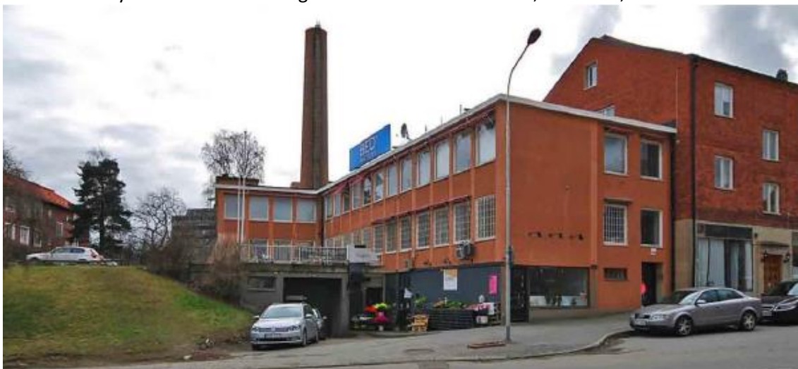
Figur 6-1. Torsleden 8 och 9 med flerbostads- och verksamhetsbyggnader från 1944-1956.
