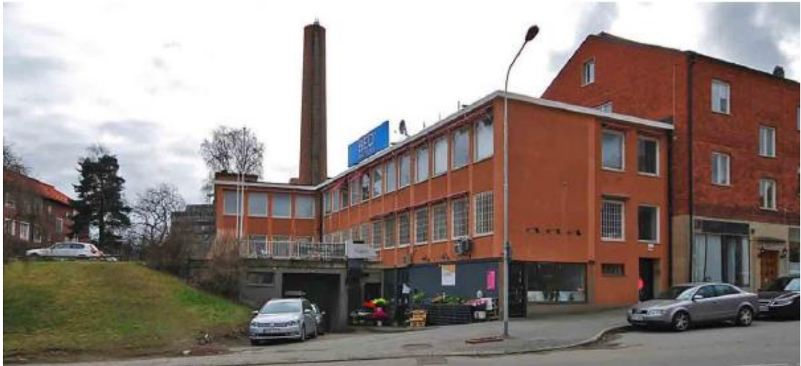
Figur 6-1. Torsleden 8 och 9 med flerbostads- och verksamhetsbyggnader från 1944-1956.
