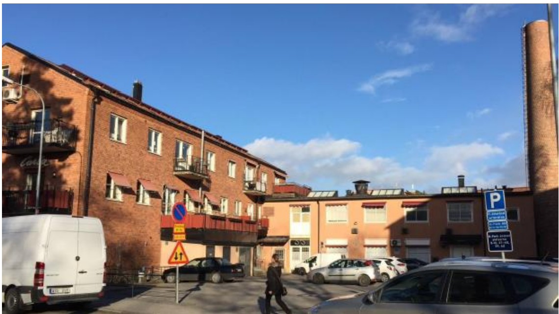
Figur 6-2. Torsleden 8 och 9 med parkering mellan husen.
