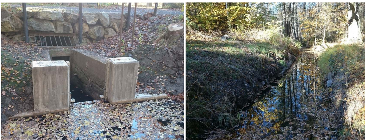
Figur 21 och 22. Mölnaån delsträcka 7 börjar uppströms Kottlasjöns regleringsdämme och utgör vattendragets djupaste delsträcka.
