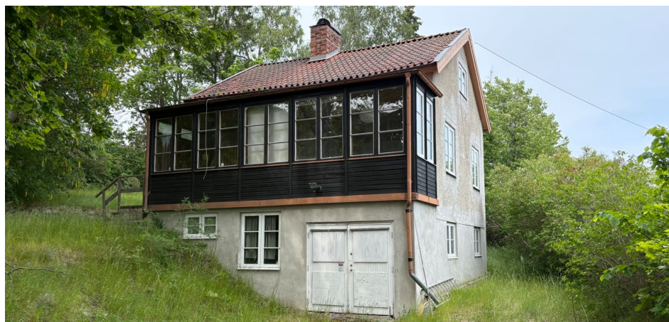
Byggnaden på Lidingö 5:140 sedd från infarten i söder.
