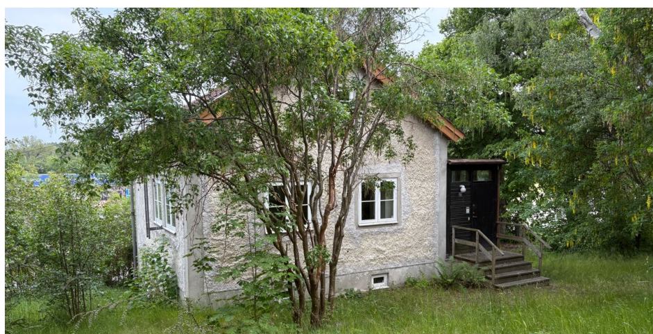
Byggnaden på Lidingö 5:140 sedd från väster.
