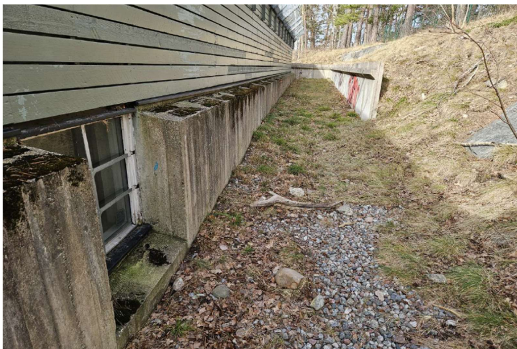
Bergsyta som överlagras av gräs och skog vid planområdets norra byggnad (Killingens förskola). Notera fönster relativt nära markytan.
