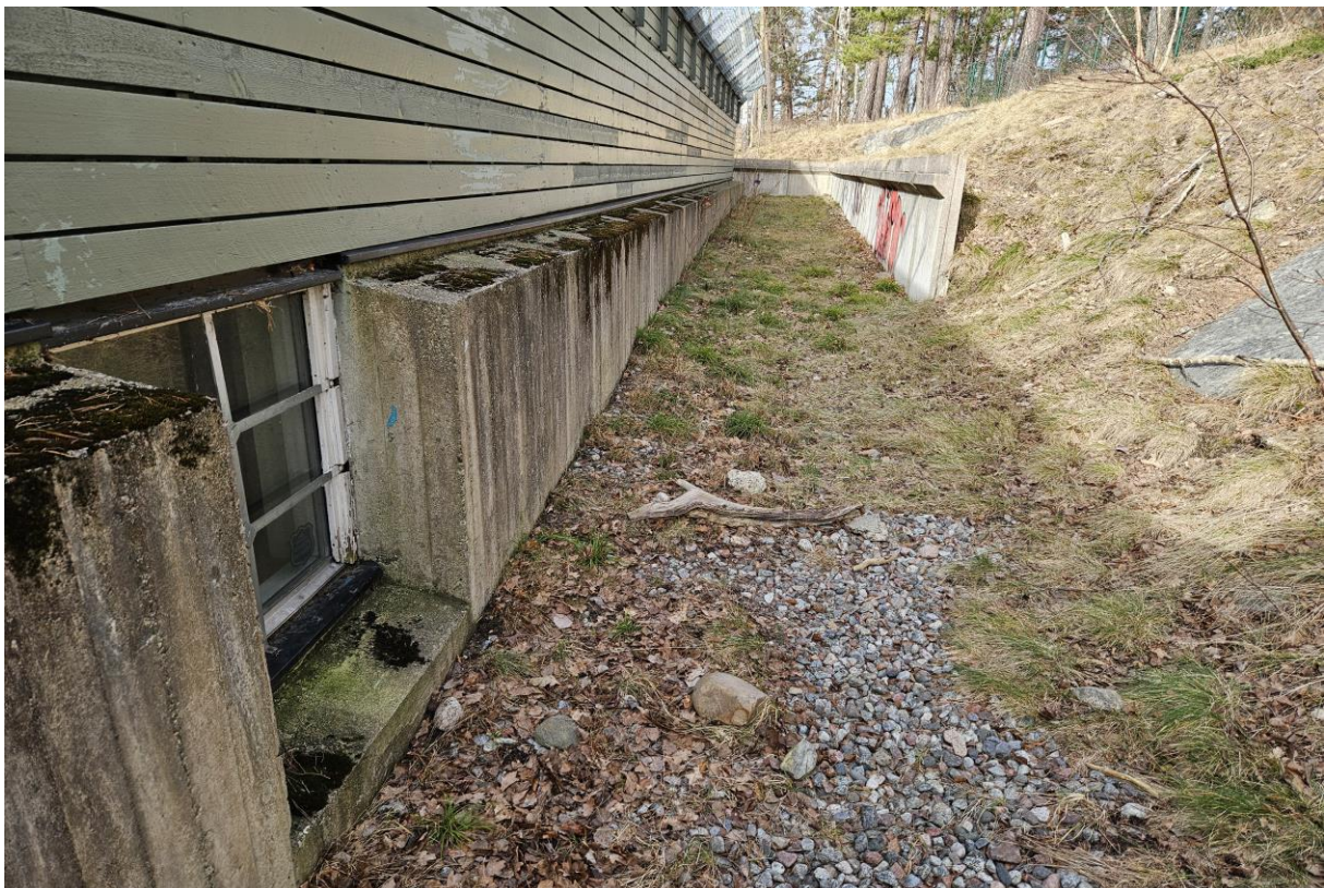
Figur 4.6. Bergsyta som överlagras av gräs och skog vid planområdets norra byggnad (Killingens förskola). Notera fönster relativt nära markytan.
