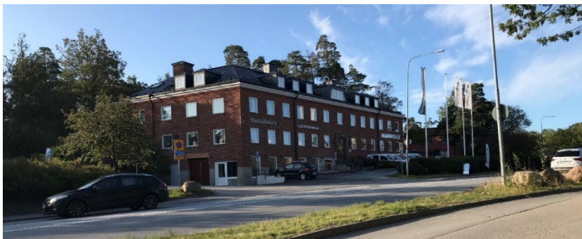
Kontorsbyggnaden på fastigheten Lejonet 28.
