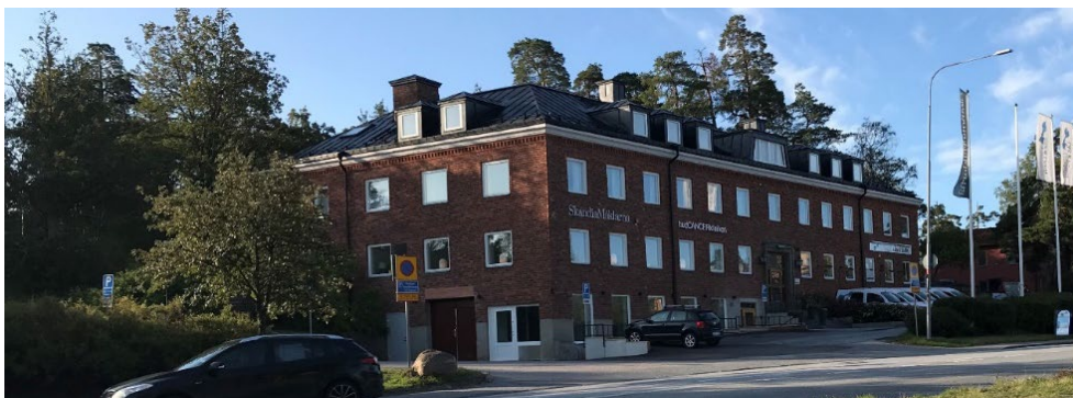
Byggnaden på fastigheten Lejonet 28.
