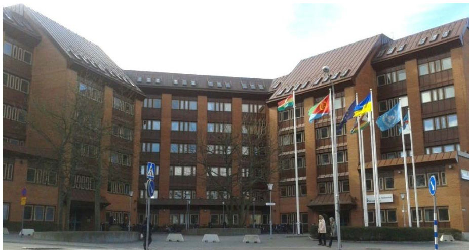
Kontors- och vårdbyggnaden på Härjedalen 16 sett från norr
